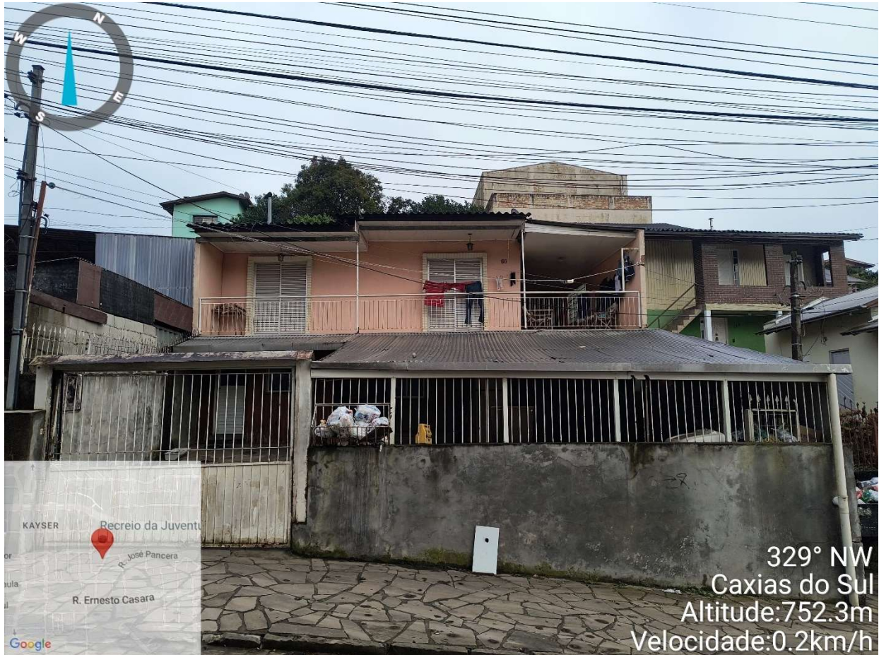
Foto 1 – Fachada e Coordenadas – Fonte: Autor
